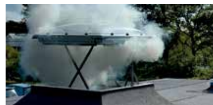
Okno oddymiające CSP
