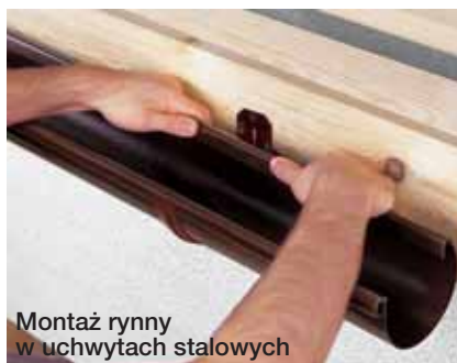
Montaż złączki rynny
