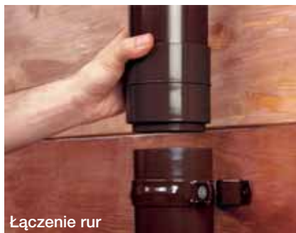
Montaż rur do ściany murowej
