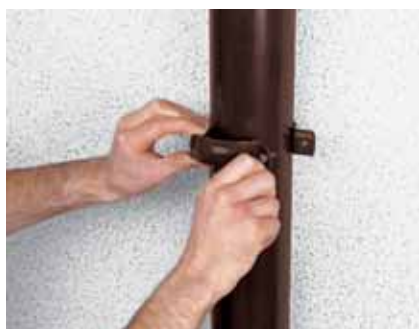
Montaż rur na ścianie drewnianej lub metalowej
